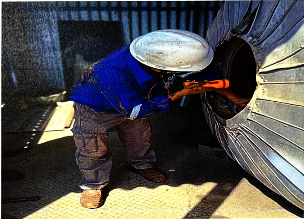
ตรวจสอบสภาพ Steam Drum( Drum Internal)
