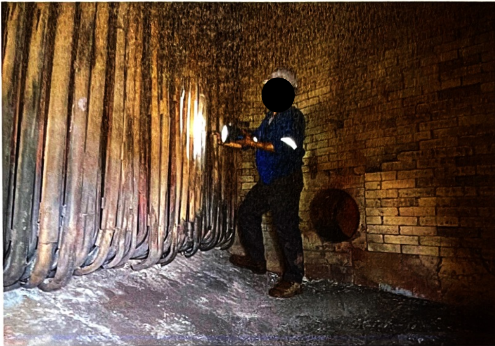
ตรวจ Secondary Superheater
