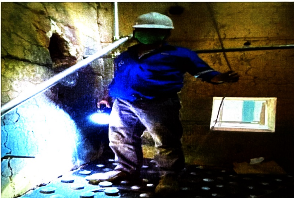
ตรวจสอบสภาพ Furnace
